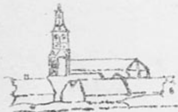
ETAING CH. looking N.
